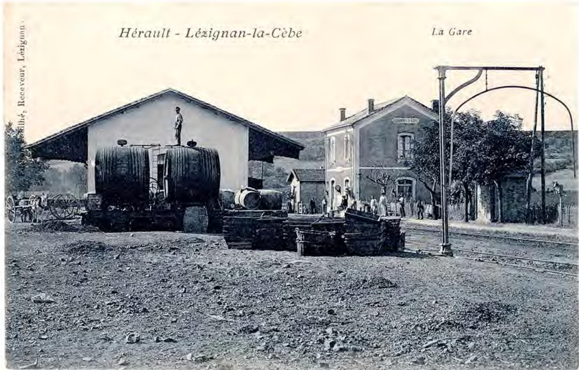
La gare en 1906. Au fond, au centre, la maison de la garde-barrière, puis la gare des voyageurs. Plus avant, entouré d'arbres, se trouve le « chalet de nécessité » et enfin à droite, en avant plan, le portique de ravitaillement en eau des locomotives à vapeur. À gauche, la halle des marchandises, des charrettes pour le transport local, un wagon bi-foudres en cours de remplissage avec une pompe manuelle à roue et divers objets viticoles.
