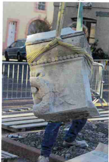
Fig. 24 - Une partie du piédestal.
