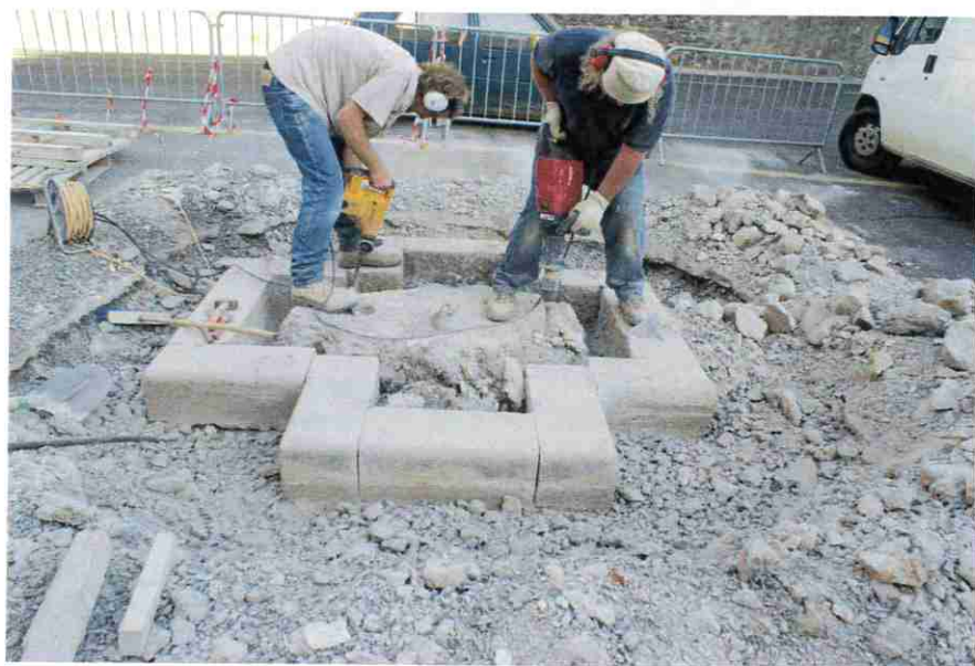
Fig. 25 - Socle initial du monument en basalte bulleux de la carrière communale. Il avait la forme d'une croix grecque. En 2009 il a été rallongé à l'avant et à l'arrière du monument.
