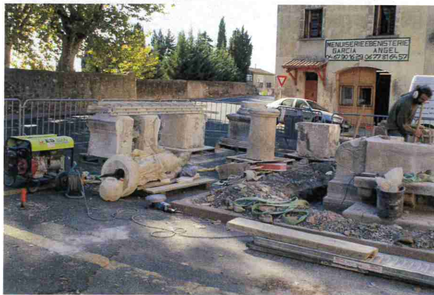
Fig. 23 - Autre aspect du chantier le même jour.
