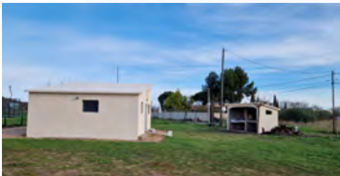
Local des chasseurs à l'ancien stade
