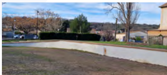
Sous-bassement ancien quai de gare côté esplanade.
