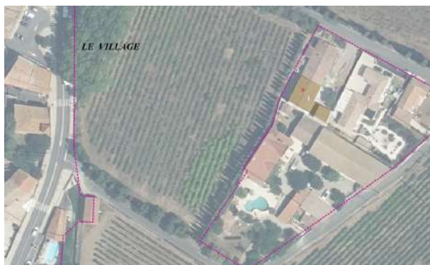
Figure 10. Sous densité apparente : création de 3 logements (en haut) et d'1 logement (en bas). Source : orthophotos 2024, IGN.
