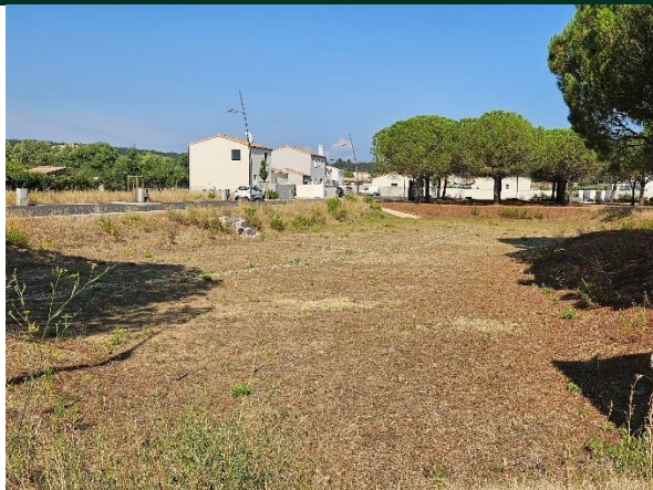
Bassin de rétention
