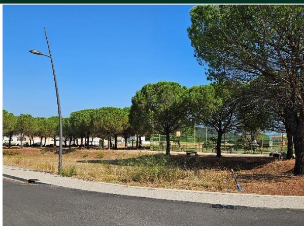
Bassin de rétention et city
