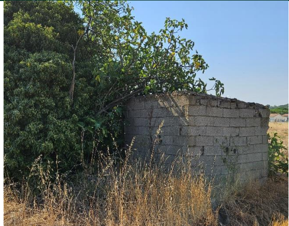
Bâti en parpaing avec végétation favorable aux reptiles
