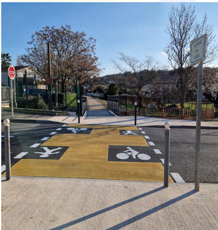
Aménagement cyclable avenue de la Gare
